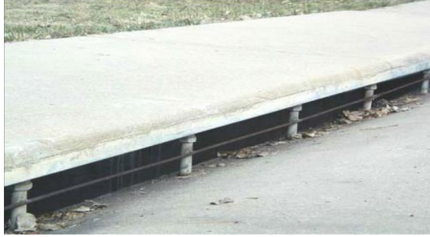
Şekil 7.13 Bordür taşında bırakılan çukurlaştırılmış (basınçlı) giriş (Avcuoğlu, 2008)
