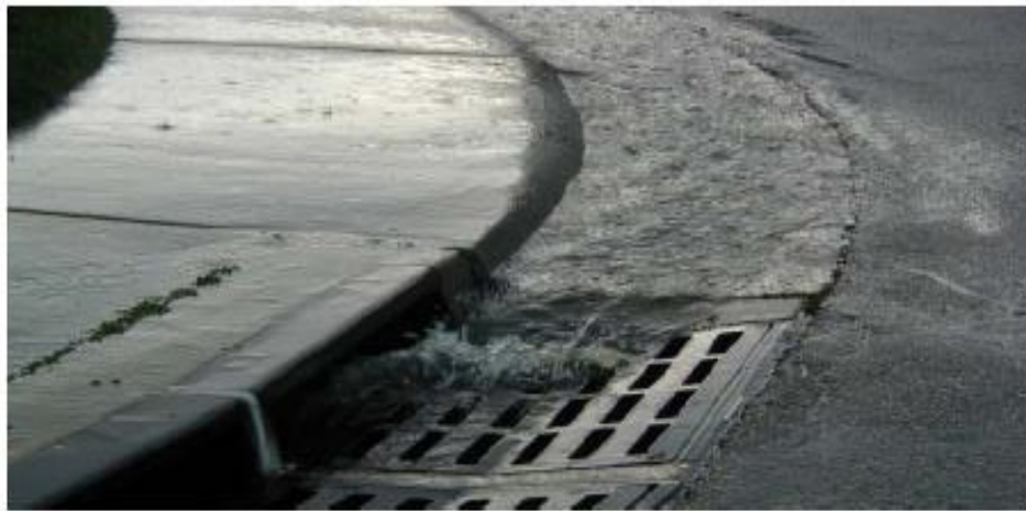
Şekil 7.1 Meskûn bölge drenajının yağmursuyu giriş elemanı (Avcuoğlu, 2008)
