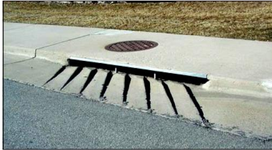
Şekil 7.14 Bordürde teşkil edilen saptırcılı giriş (Avcuoğlu, 2008)
