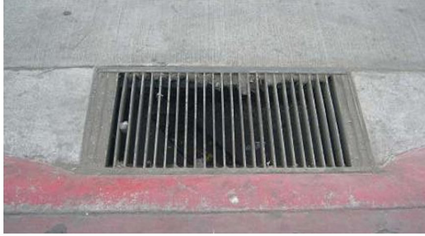
Şekil 7.15 Cadde arkında bırakılan çukurlaştırılmış ızgaralı giriş (Avcuoğlu, 2008)
