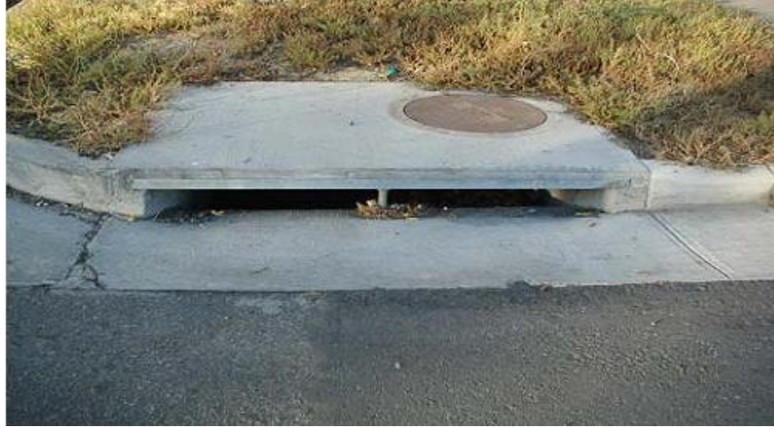
Şekil 7.12. Bordür taşında bırakılan düz giriş (Avcuoğlu, 2008)
