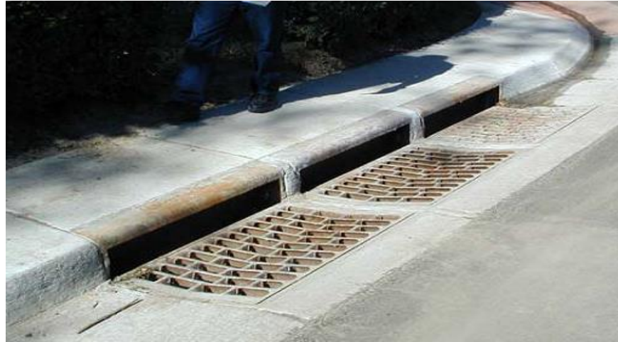
Şekil 7.17 Yan yana konulmuş üçlü birleşik girişler (Avcuoğlu, 2008)
