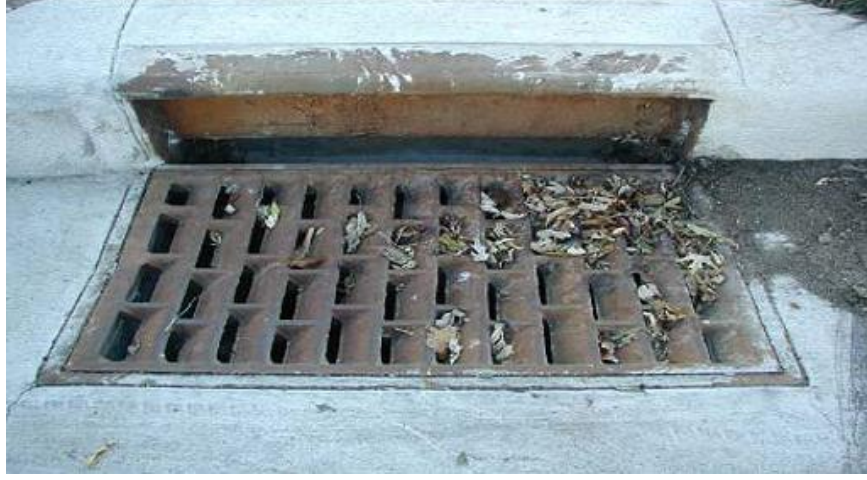
Şekil 7.16 Ark ve bordür girişinin birlikte çalıştığı birleşik giriş (kombine giriş) (Avcuoğlu, 2008)
