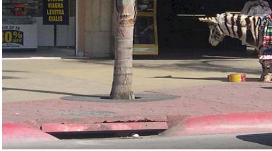
Şekil 7.11 Kent yollarında yerleştirilen bordür girişi (Avcuoğlu, 2008)
