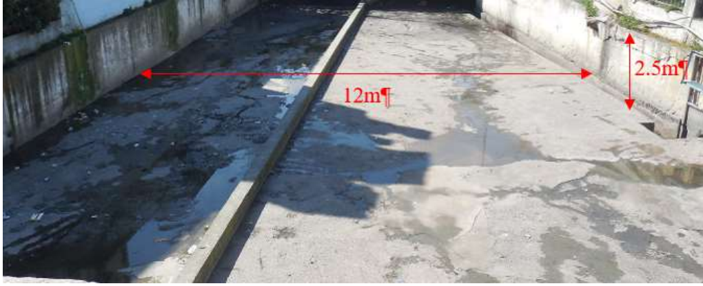
Şekil 25 Çamaşırçı deresi 199 ila 0 kesitleri arasındaki kesit görünümü
