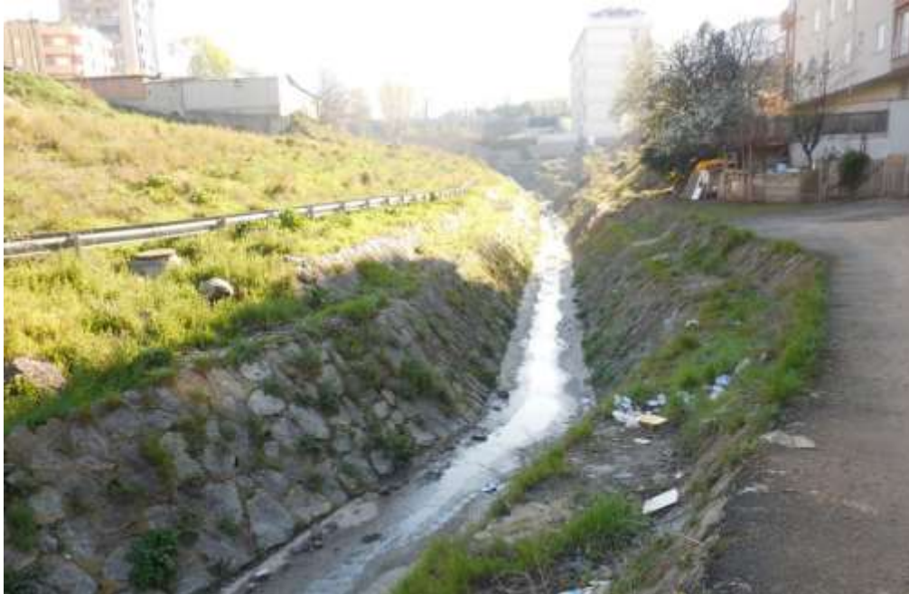
Şekil 3 Çamaşırcı deresi 5409-5060 nolu kesitler arası görünüm
