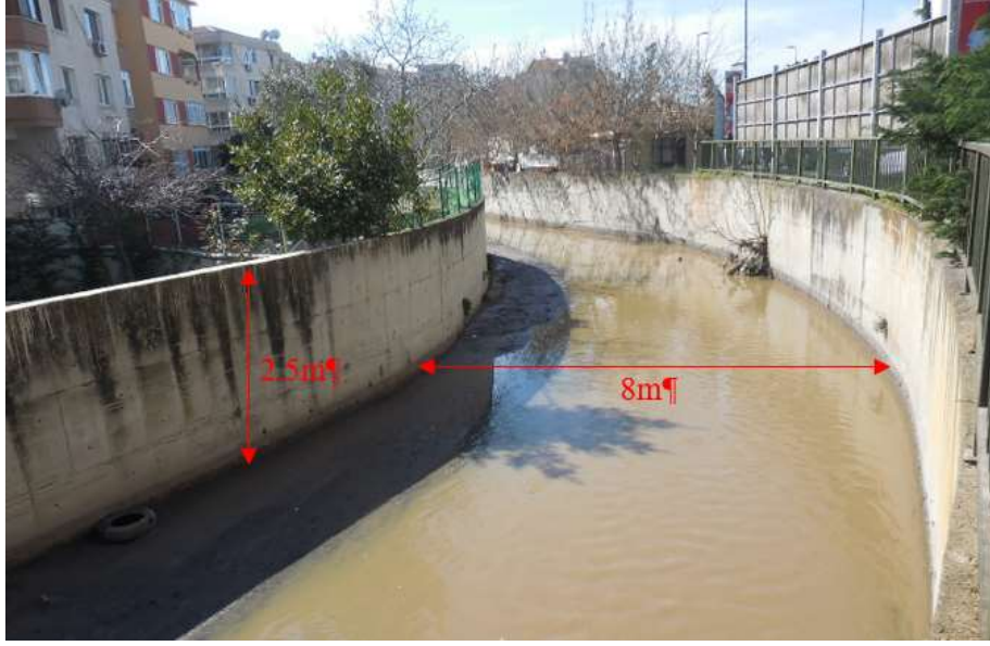
Şekil 23 Çamaşırcı deresi 585m ile 300m arası kesit görünümü
